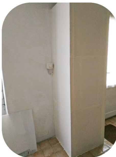
Coffrage du ventilateur et du conduit
